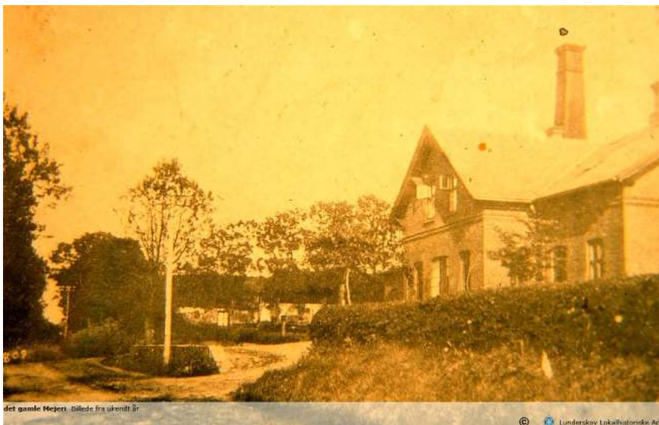
Det gamle mejeri i Skanderup. Fotografiet må være fra før 1922, hvor mejeriet ombyggedes til Valgmenighedskirke. Ombygningen har været betydelig, kan man se på vinduer og murværk og det efterfølgende billede af den ombyggede kirke, hvor vi har Skanderup Valgmenighedskirke,
