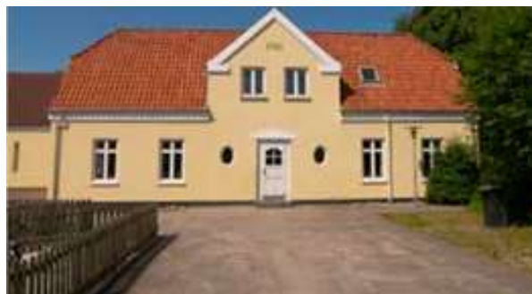
Friskole fra 1918, denne bygning fra 1920
